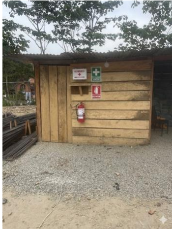
Fotografía 3: Extintor y botiquín en obra
