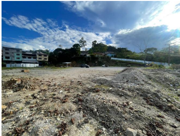
Fotografía 1: Inspección inicial del lugar de trabajo
