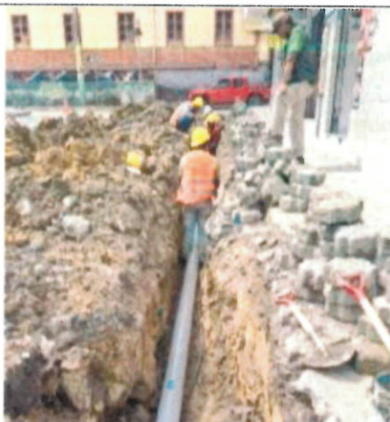
Instalación de tubería para la red de distribución de agua potable
