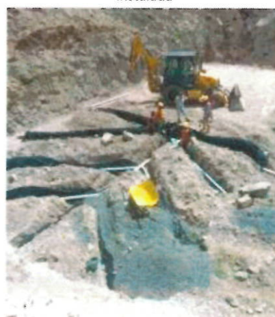
Construcción de drenes para la planta de tratamiento de agua potable en Santa Rosa
