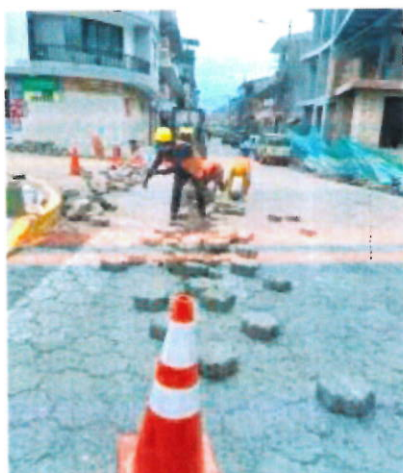
Desadoquinado para la excavación en la red de distribución
