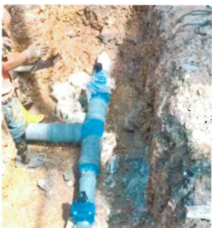
Colocación de válvulas de regulación en red de distribución
