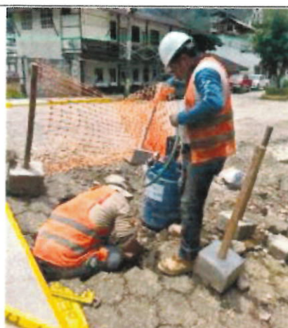
Realización de pruebas de presión en la tubería instalada
