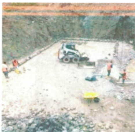
Relleno compactado con material de mejoramiento para la implantación de unidades de la PTAP
