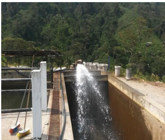
Entrada del agua Cruda a la planta
