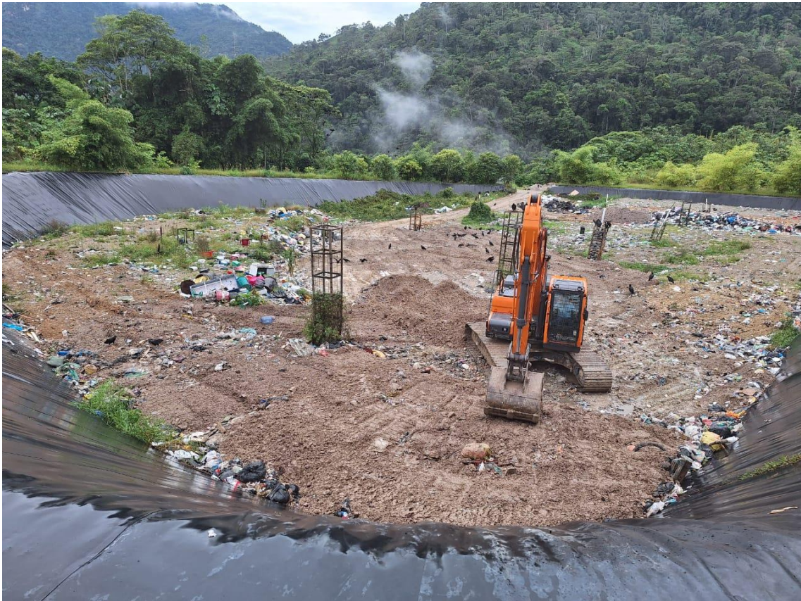
Celda actual relleno sanitario
