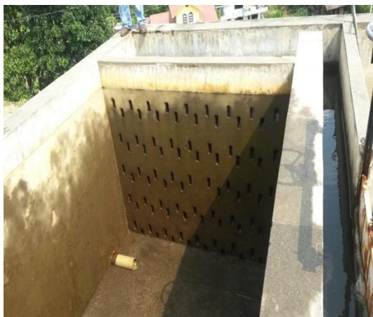
Entrada del agua Cruda a la planta
