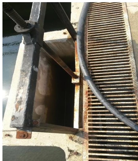
Estado de compuertas y rejillas de la planta
