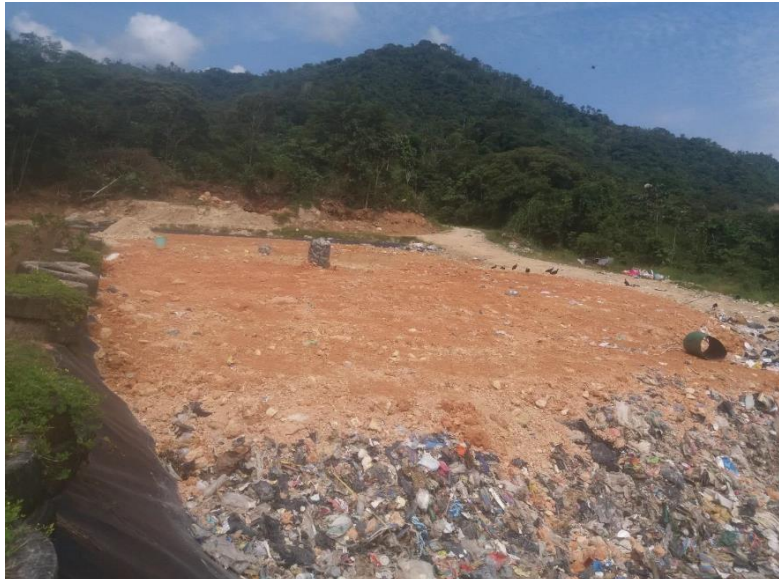
FOTOGRAFÍA No. 30 ESTADO DE LA CELDA DEL RELLENO SANITARIO.
