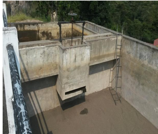
Cámara de Entrada del filtro Lento
