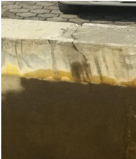
Estado de Paredes del Filtro
