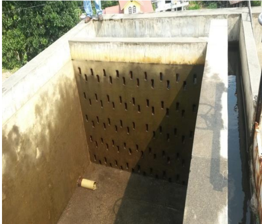
Sedimentador y pantalla deflectora
