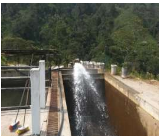
Entrada del agua Cruda a la planta
