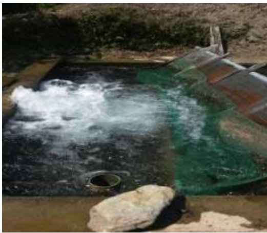
Rebose del agua en cámara de entrada
