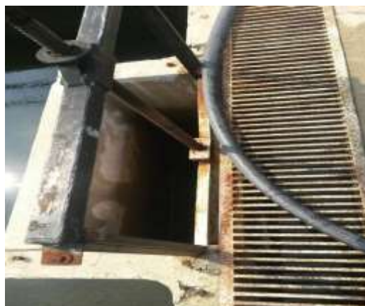
Estado de compuertas y rejillas de la planta
