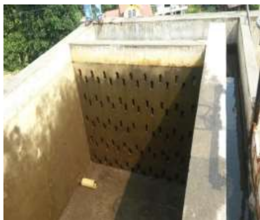
Entrada del agua Cruda a la planta
