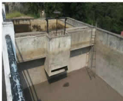
Cámara de Entrada del filtro Lento
