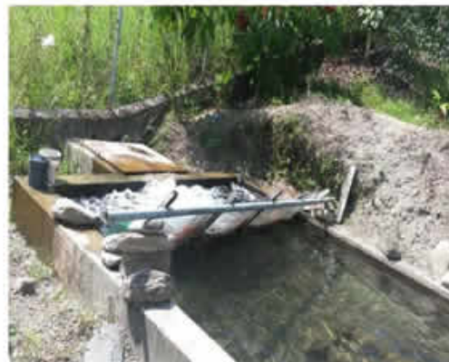
Malla para Evitar Deterioro del lecho filtrante
