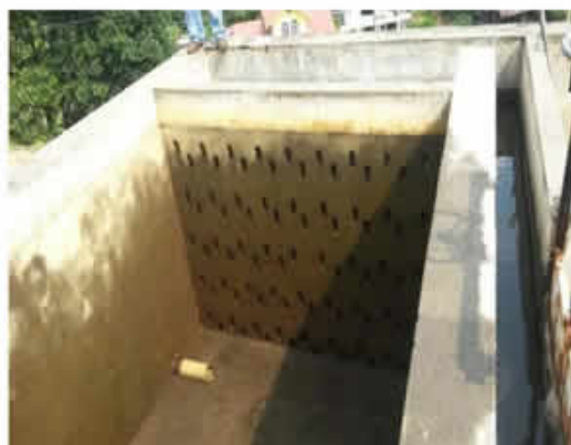
Sedimentador y pantalla deflectora
