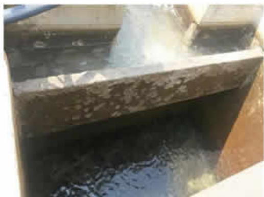
Estado de paredes del canal de entrada de la planta
