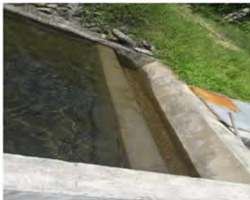
Vertimiento de Excesos en cámara de Salida durante la Operación del filtro
