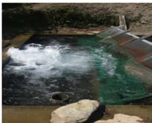
Rebose del agua en cámara de entrada
