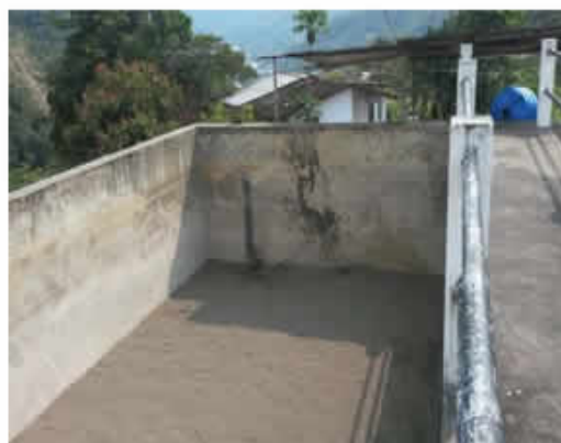
Lecho filtrante de arena del filtro lento
