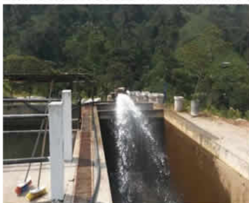
Entrada del agua Cruda a la planta
